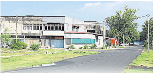
■城镇花园翡翠路已顺利完成重铺工程。
